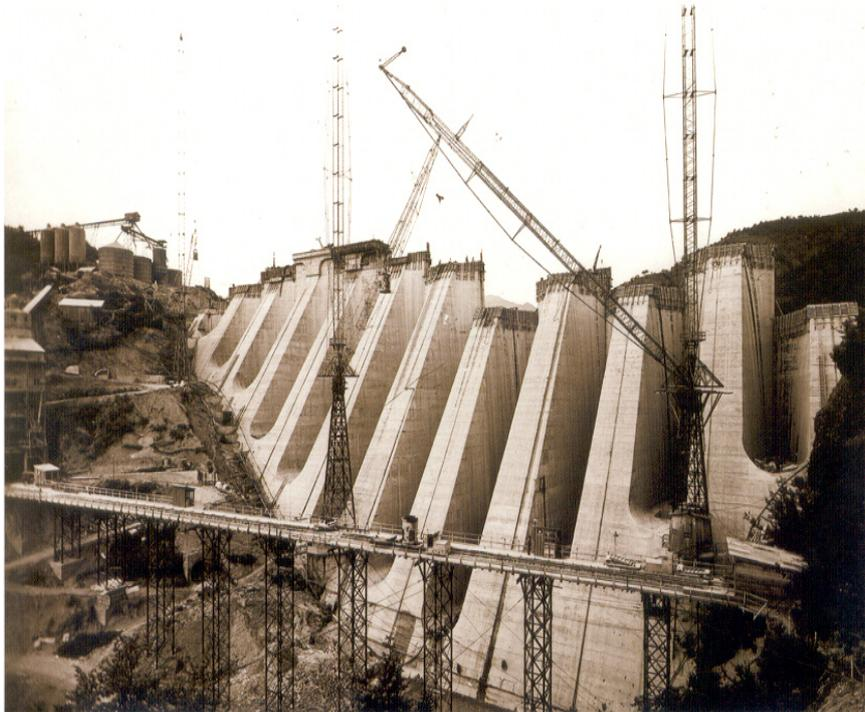
Fig.40: La diga del Brugneto in costruzione nel 1959 (fonte: Museo Fondazione AMGA)
