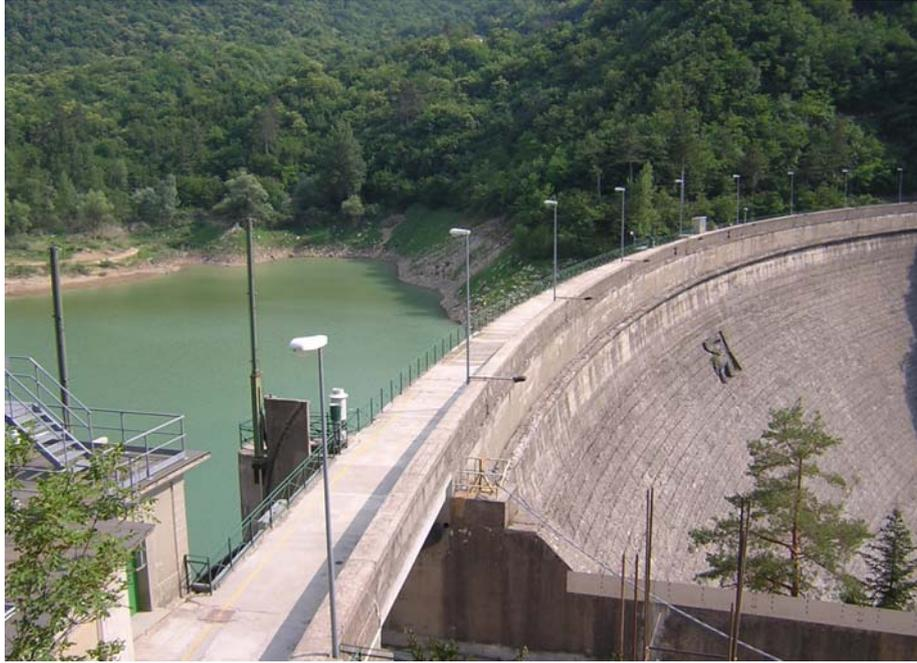
*Fig. 34: La diga ad arco gravità dell'acquedotto Val Noci (fonte: archivio Temporelli)*
