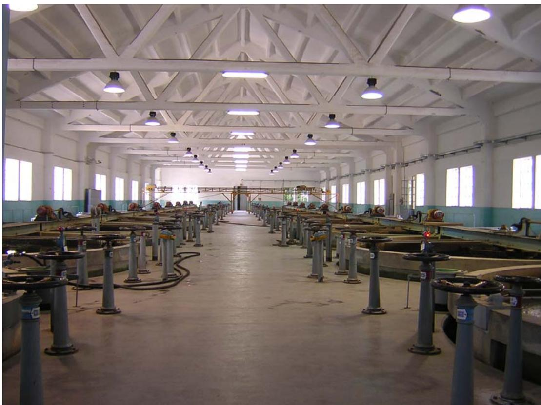
*Fig.28: I 20 filtri rapidi a sabbia in uso presso l'impianto di Isoverde (fonte: archivio Temporelli)*
