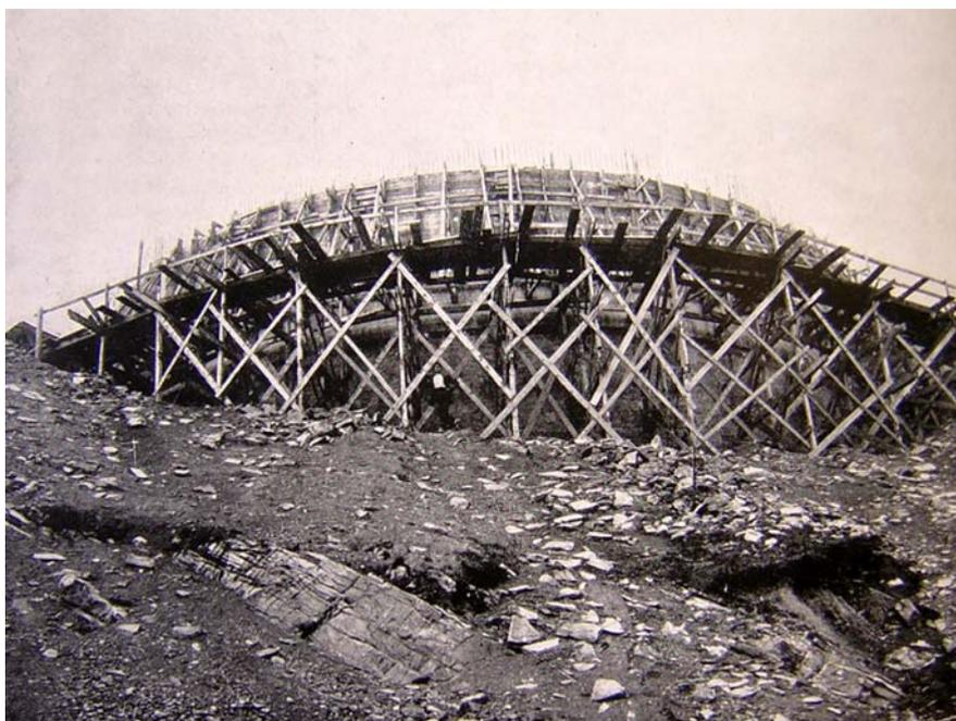
*Fig. 36: Il serbatoio sullo Sperone in costruzione intorno al 1930 (fonte: Museo Fondazione AMGA)*
