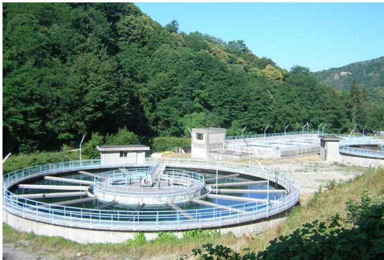
*Fig.19: I chiariflocculatori "accelerator" in sostituzione dei filtri Puech-Chabal (fonte: archivio Temporelli)*
